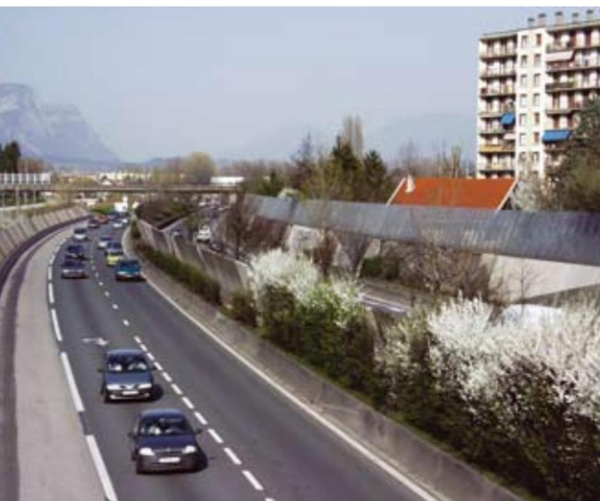
*Des murs antibruit permettent de limiter les nuisances sonores pour les riverains proches des axes à grande circulation.*
